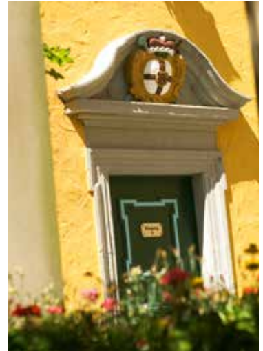
Wappen zieren die Eingänge der zentralen Vierflügelanlage.
