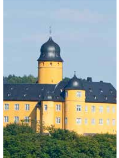
Ansicht des Hauptturmes (Bergfried)
